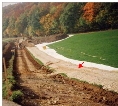
Abb. 1: Fertige Baupiste (roter Pfeil)
