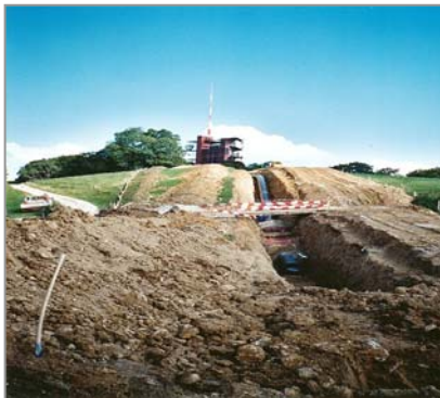
Abb. 2: Aushubpiste im offenen Feld
