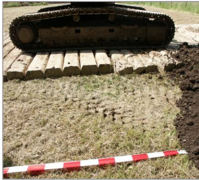
Abb. 2: von Bagger selbst über Kopf verlegt
